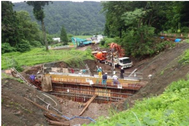
砂防堰堤工事
