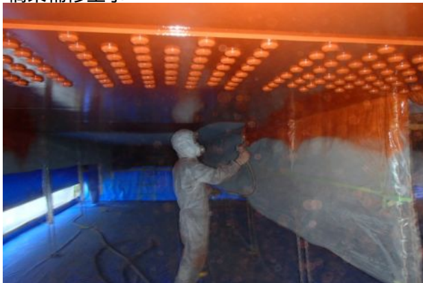
橋梁補修工事
